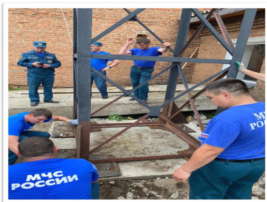
Установка первой секции АМС.
