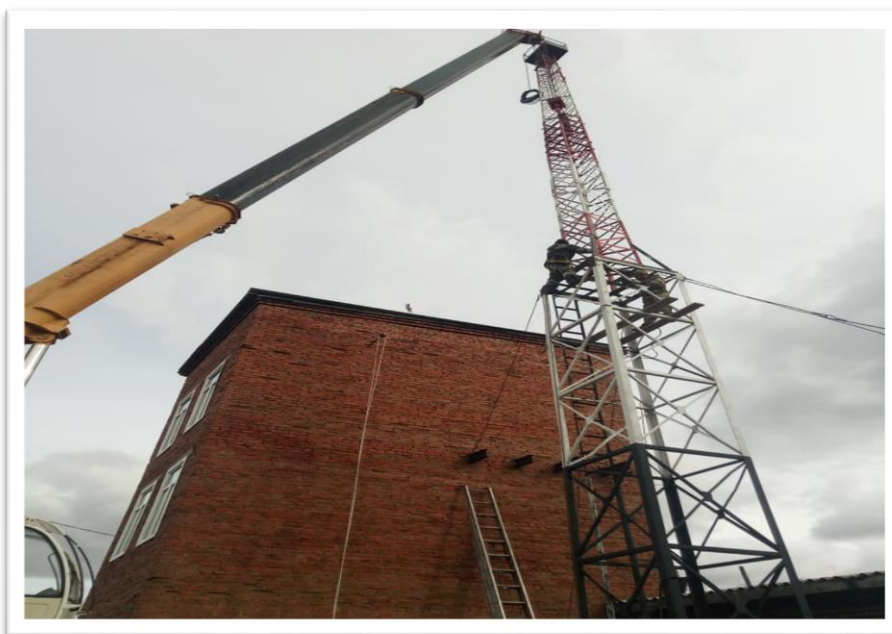
Стыковка секций и обваривание стыков АМС.
