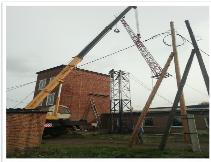
Стыковка секций и обваривание стыков АМС.
