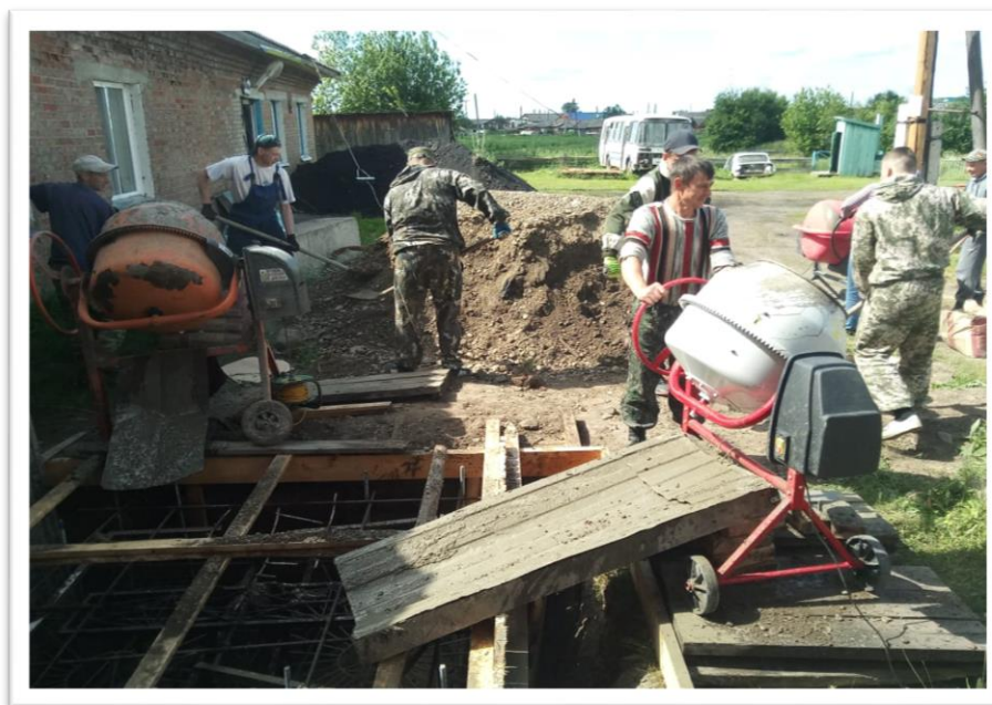
Заливка бетонного основания.
